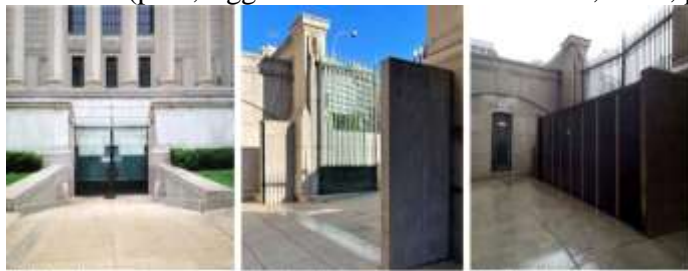
شكل رقم (3) يوضح بوابات الفيضانات الذاتية بمبنى الأرشيف الوطني الأمريكي في واشنطن
